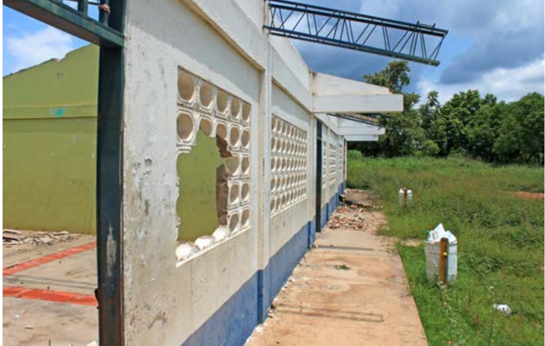
Imagen del desmantelamiento de la Escuela de Plan Bonito después de la salida de la comunidad.
