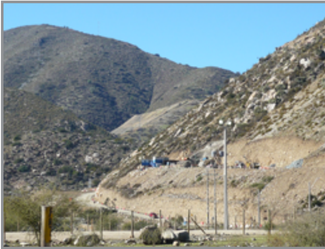
Erosión cerca de un camino a la mina. Mina Pelambres, Chile Foto: Rocío Ávila Fernández
