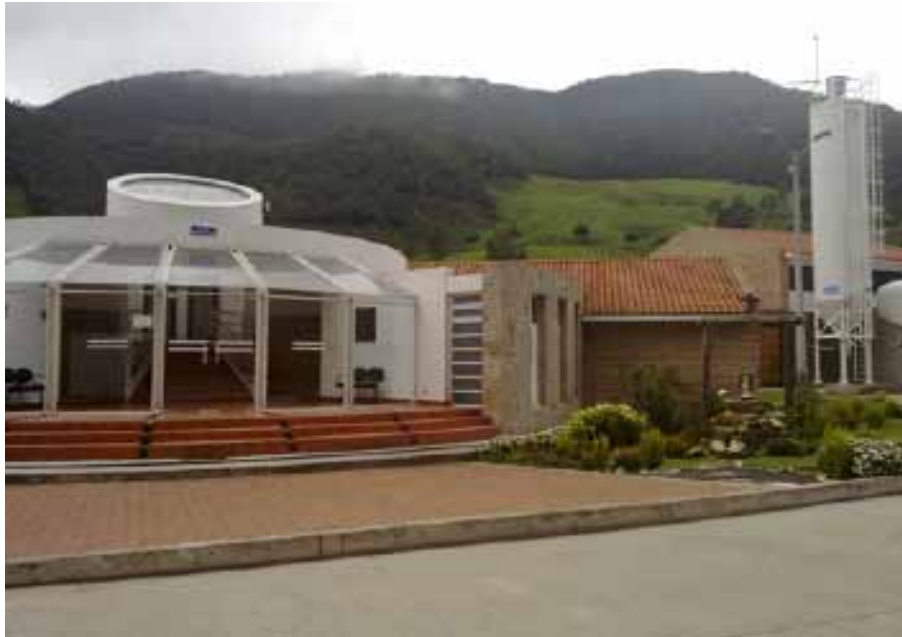
Planta de agua potable en Sustag que ETAPA procesa 500 l/s desde el 2010
