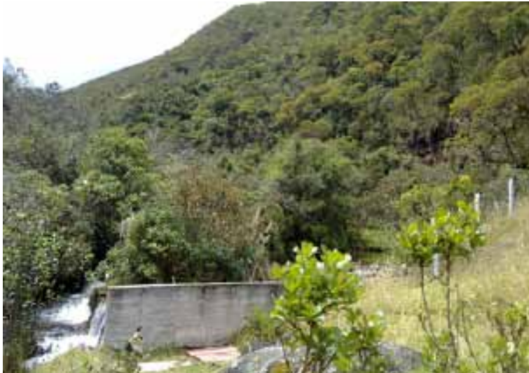
Captación del río Irkis para usuarios del sistema comunitario Tarqui y Victoria del Portete.
